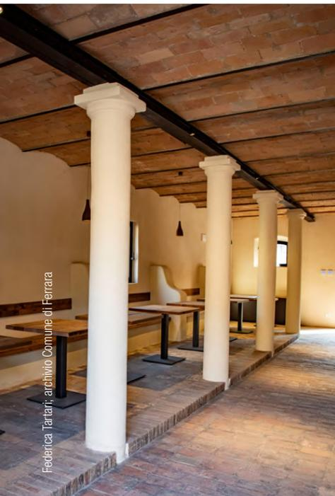
Uno scorcio dell'ex stalla, rifinita con tavelle in cotto di recupero, contropareti termoisolanti rivestite con intonaco in argilla e soffitti a voltine attentamente restaurati
